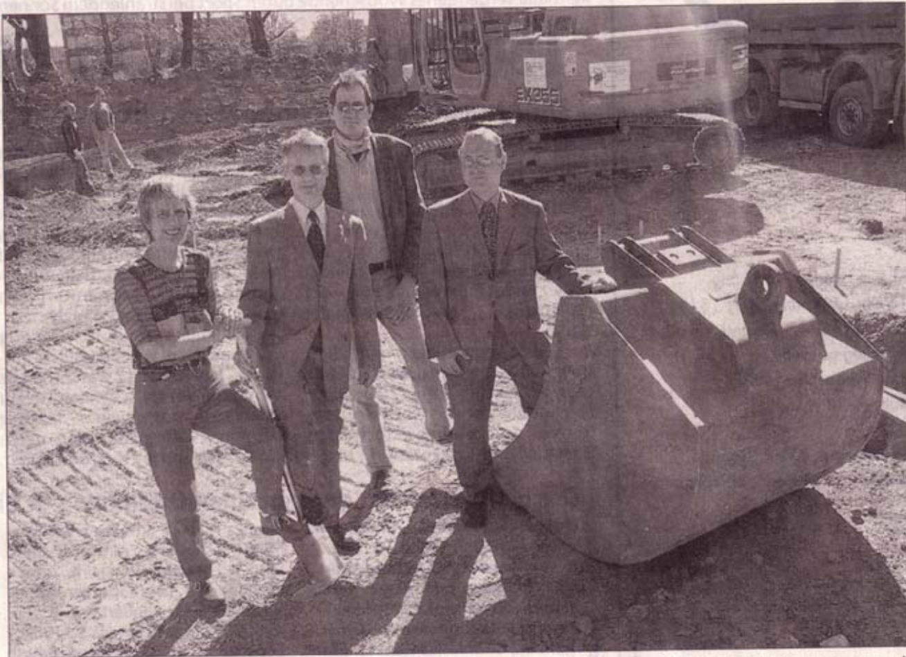
Dem ersten Spatenstich für das Projekt Betreutes Wohnen folgen die Bagger: An der Baustelle in Simmerath hoffen unter anderem Elfriede Theissen vom Pflegedienst, Simmeraths Beigeordneter Karl-Heinz Hermanns (li.) und Stefan Schepers von der Gesellschaft bonafide (hinten) auf gutes Gelingen. Foto: P. Stollenwerk
