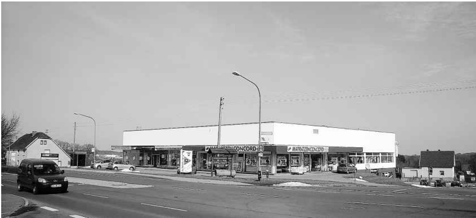
Der Gewerbekomplex an der Ecke Faulenbruch-/Bundesstraße soll, optisch aufgewertet, Teil des neuen Nahversorgungszentrums „Im Vennhof“ werden. Zwei leerstehende Einfamilienhäuser an der Bundesstraße (links) und Faulenbruchstraße müssen den Neubauten weichen, die Erschließung von der Bundesstraße her soll über einen Kreisverkehr an der oberen Abgrenzung erfolgen. Foto: Helga Giesen
