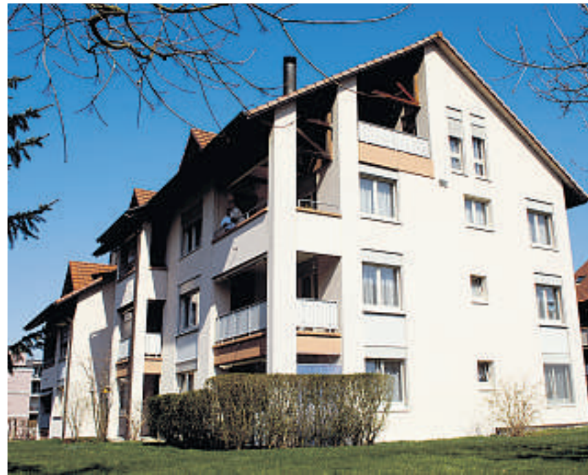
Goldinger Verwaltungsmandat seit nunmehr 20 Jahren: Mehrfamilienhäuser am Frauenfelder Wellhauserweg. Bilder: Patrick Frischknecht
